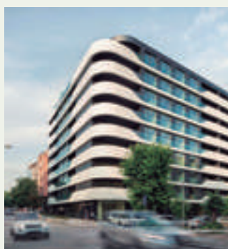
Különleges lakóépület Bulgáriában, hatékony épületgépészeti megoldással. Aquarea
