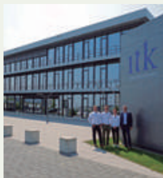
ITK Engineering GmbH. Innovatív irodaépület Németországban. ECOi - PACi
